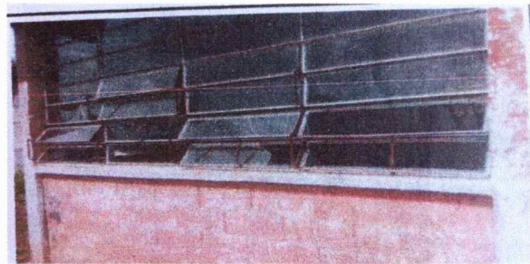
Foto 6: Ventanas sin mantenimiento, con daños ocasionados por antigüedad.
